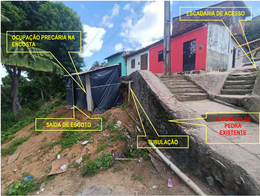
Figura 5.3. - Foto da parte superior da encosta, nota-se a presença de uma alvenaria de pedra no talude com altura variável, a escadaria de acesso e uma ocupação precária na crista do talude.
