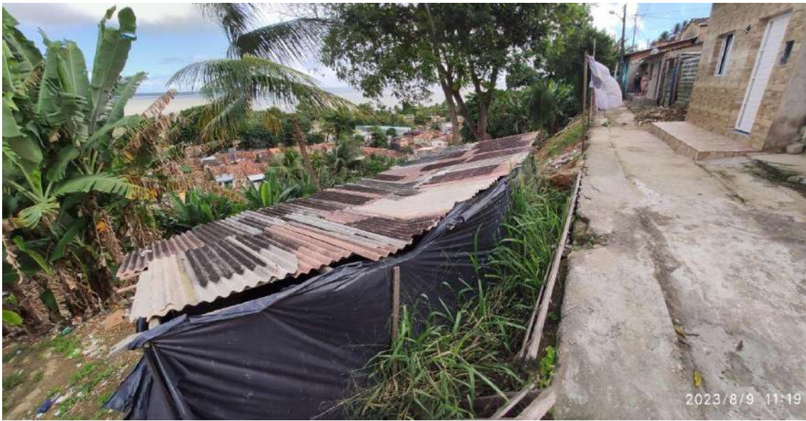
Figura 5.4. - Foto do acesso existente na crista do talude do Ponto 07, bastante deteriorado, a jusante presença de bananeiras.
