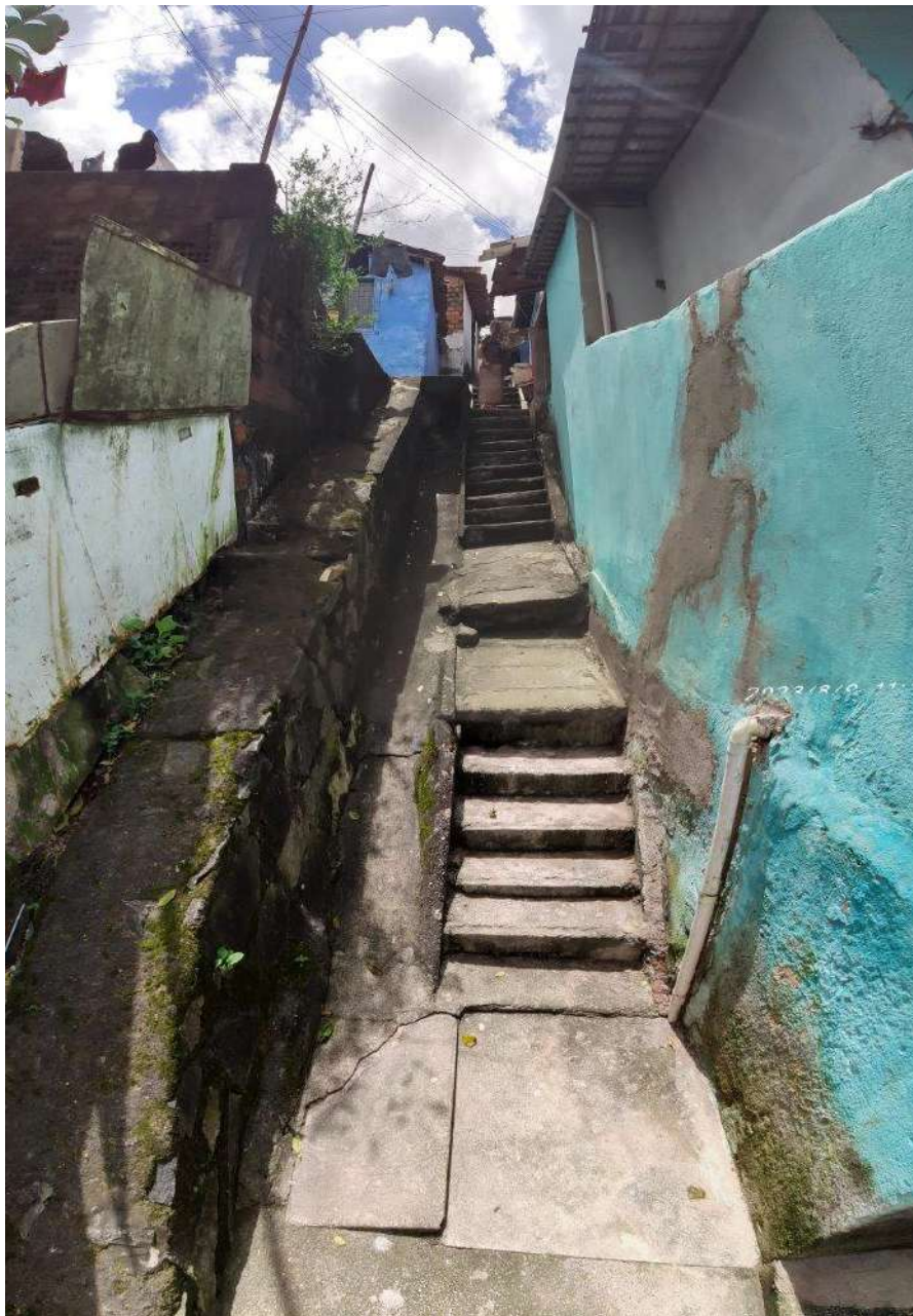
Figura 5.6.- Escadaria que liga a crista d talude do Ponto 07 com a rua Nossa Senhora da Conceição, sob esta escadaria desce uma tubulação que conduz as águas coletadas nas ruas a montante.
