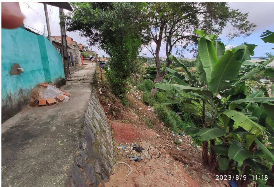
Figura 5.4.- Imagem tirada desde a região mais à direita, observar presença de contenção em alvenaria de pedra e grande quantidade de lixo/entulho.
