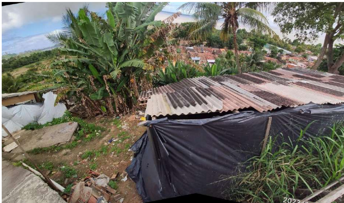
Figura 5.2.- Outra imagem da face do talude, presença de bananeiras, lixo/entulho.
