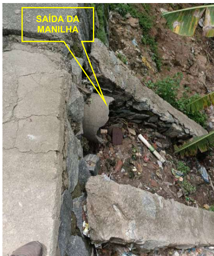
Figura 5.4. - Foto de uma manilha de 400mm localizada a esquerda (vista frontal) do talude que coleta águas a montante e deságua na face do talude.
