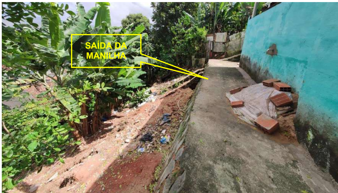
Figura 5.7.- Vista da região extrema direita da crista do talude, local onde desaguam as águas conduzidas pela tubulação que desce sob a escadaria.
